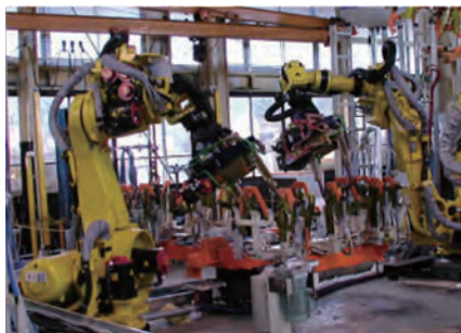
自動溶接組立設備
